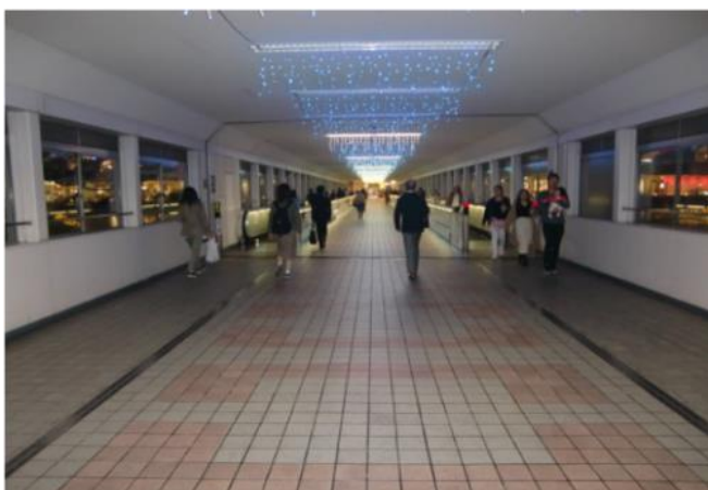
(1) かもめ歩道橋
